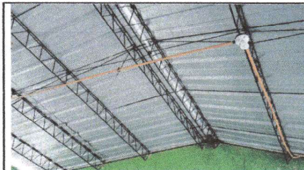
Foto 4: Instalación de cableado y colocación de focos ahorradores
