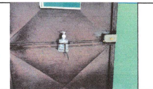
Foto 5: Intalación de chapas nuevas en aulas
